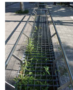
三井住友海上駿河台新館前のレインガーデン 底は土壌となっており、周囲からの雨水を浸透させて植物が生育します。
