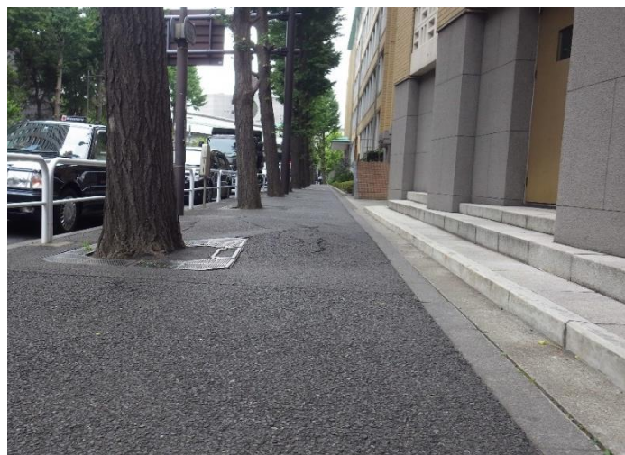
共立女子中学高等学校側歩道 根上がり部分 施工前
