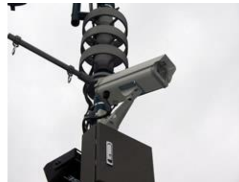
防犯カメラの設置 出典 http://www.bouhan.metro.tokyo.jp/
