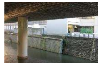
日本橋川沿いの水辺空間の状況
