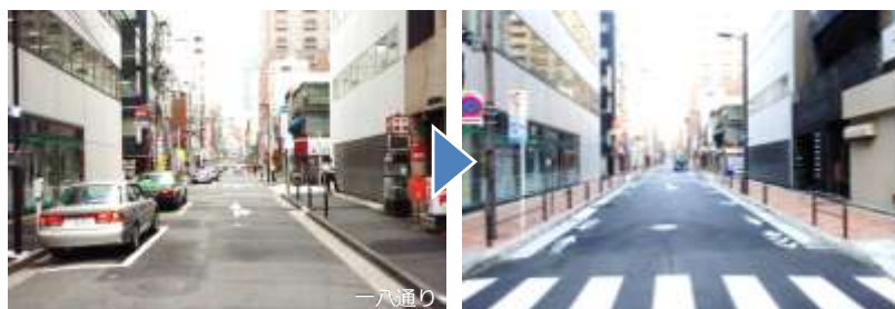
一八通り 平常時・災害時ともに人と車が安全に通行できる道路空間 (歩道拡幅・無電柱化・老朽建物の更新)
