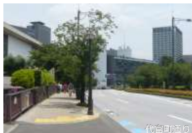
回遊軸として整備された幹線道路
