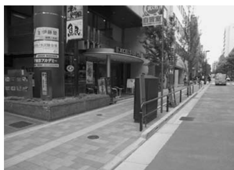
▲道路の表面温度を低下させる保水性舗装された歩道
