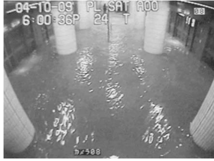
▲都内の地下鉄駅 (平成16年10月の台風22号で冠水) 【出典：国土交通省河川局】
