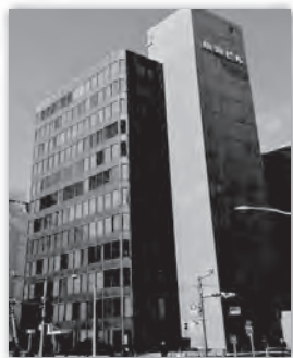
□廣瀬ビル ※テナント用貸会議室有 広めのフロアでレイアウトも自由自在
