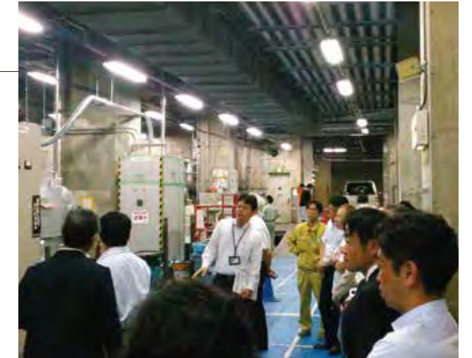
▲ 地下の熱源設備機械室を見学
