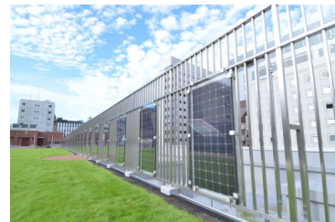
区内に導入された再生可能エネルギー (神田一橋中学校の太陽光発電)
