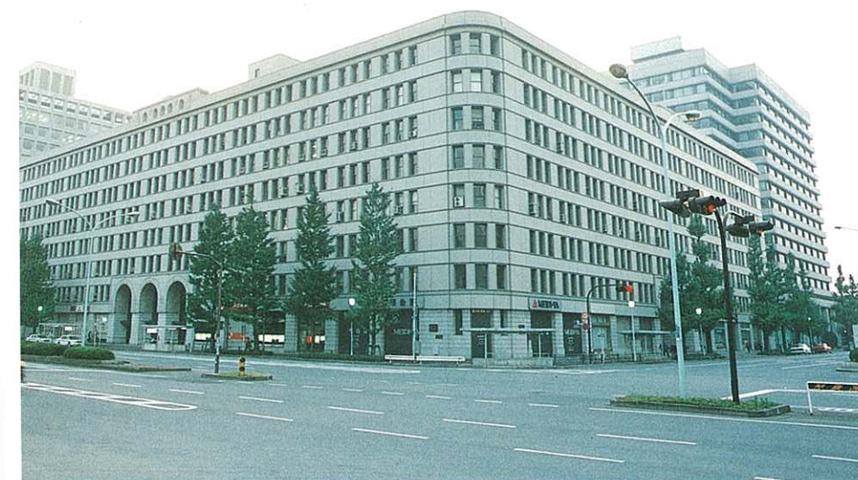
当時最先端の技術で造られたオフィスビルの代表格『丸ビル』
