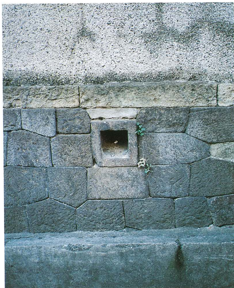
『明治大学石積み擁壁の排水用吐水口』
