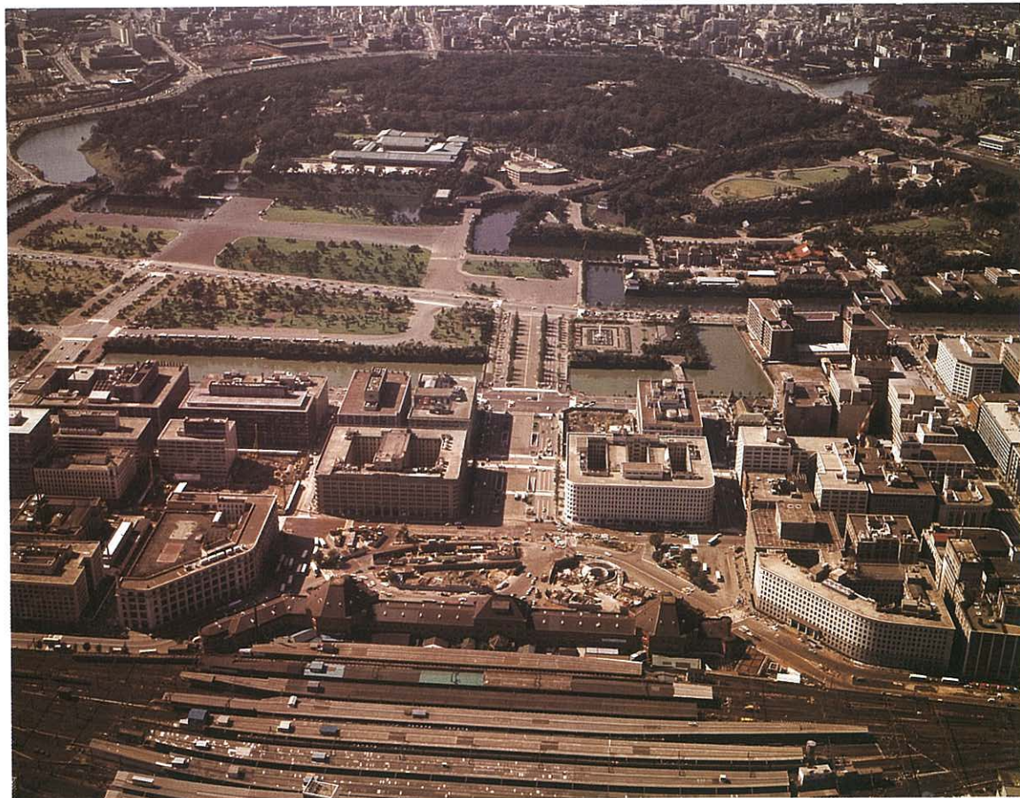
首都東京-千代田のゲートとして象徴的な『東京駅周辺』（昭和40年頃）
