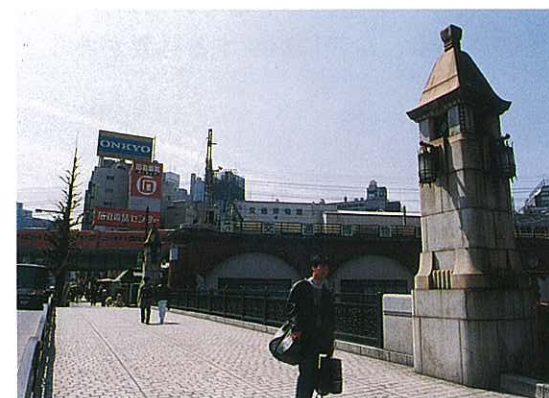
『万世橋』の欄干柱
